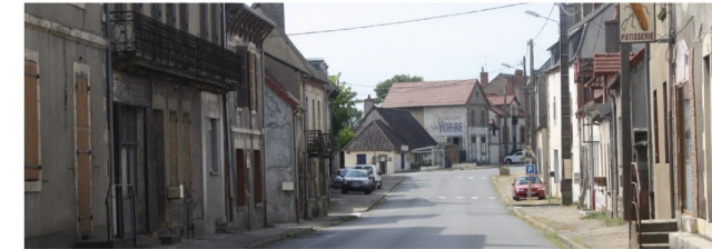
Sécurisation et mise en valeur de la RN7
